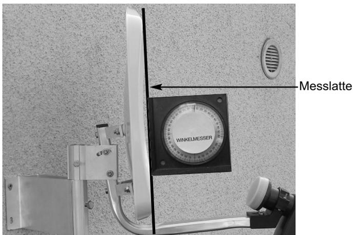
5. Lösen Sie nun die Schraube (**C**) bzw. (**B**) am Schwenkprofil und drehen Sie den Spiegel langsam in Ost- oder Westrichtung (Azimutwinkel), bis Sie das Fernsehbild des Receivers empfangen.
